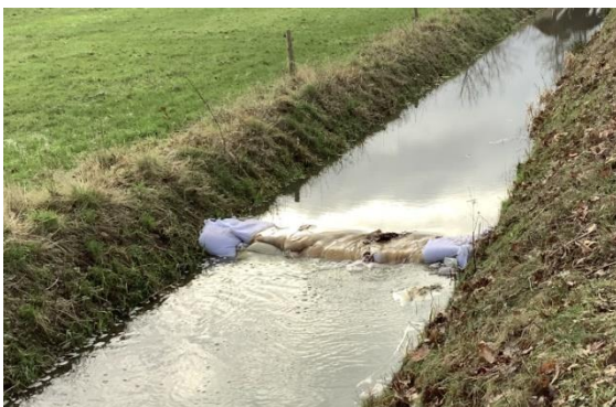
Een afdamming zodat het waterpeil wordt opgezet voor tegendruk.
