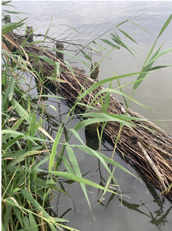
Figuur 1.2: Oeverbescherming bestaande uit palenrijen met daartussen gebonden wiepen (Foto: F. Collas).
