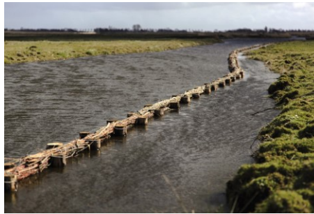
Afbeelding 2: Dubbele rij palen met rijshout
