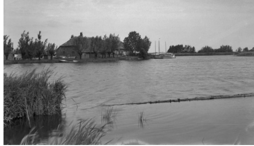
Afbeelding 4: Drijfbalk welke zorgt voor afstand tot de oever
