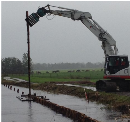
Afbeelding 1: Beschoeiing bestaande uit enkel palen
