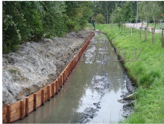
Afbeelding 2: Beschoeiing bestaande uit palen en planken
