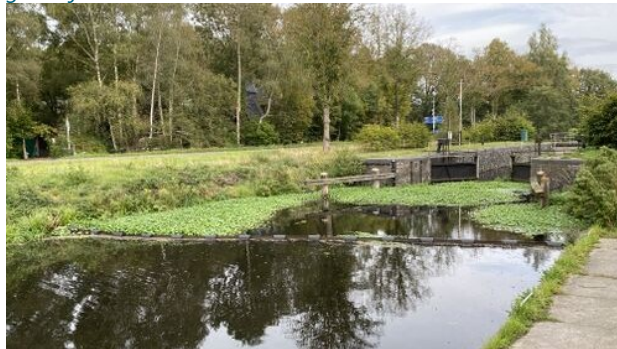
Afbeelding 1: Drijfbalk over volle breedte van vaarweg in het voorjaar
