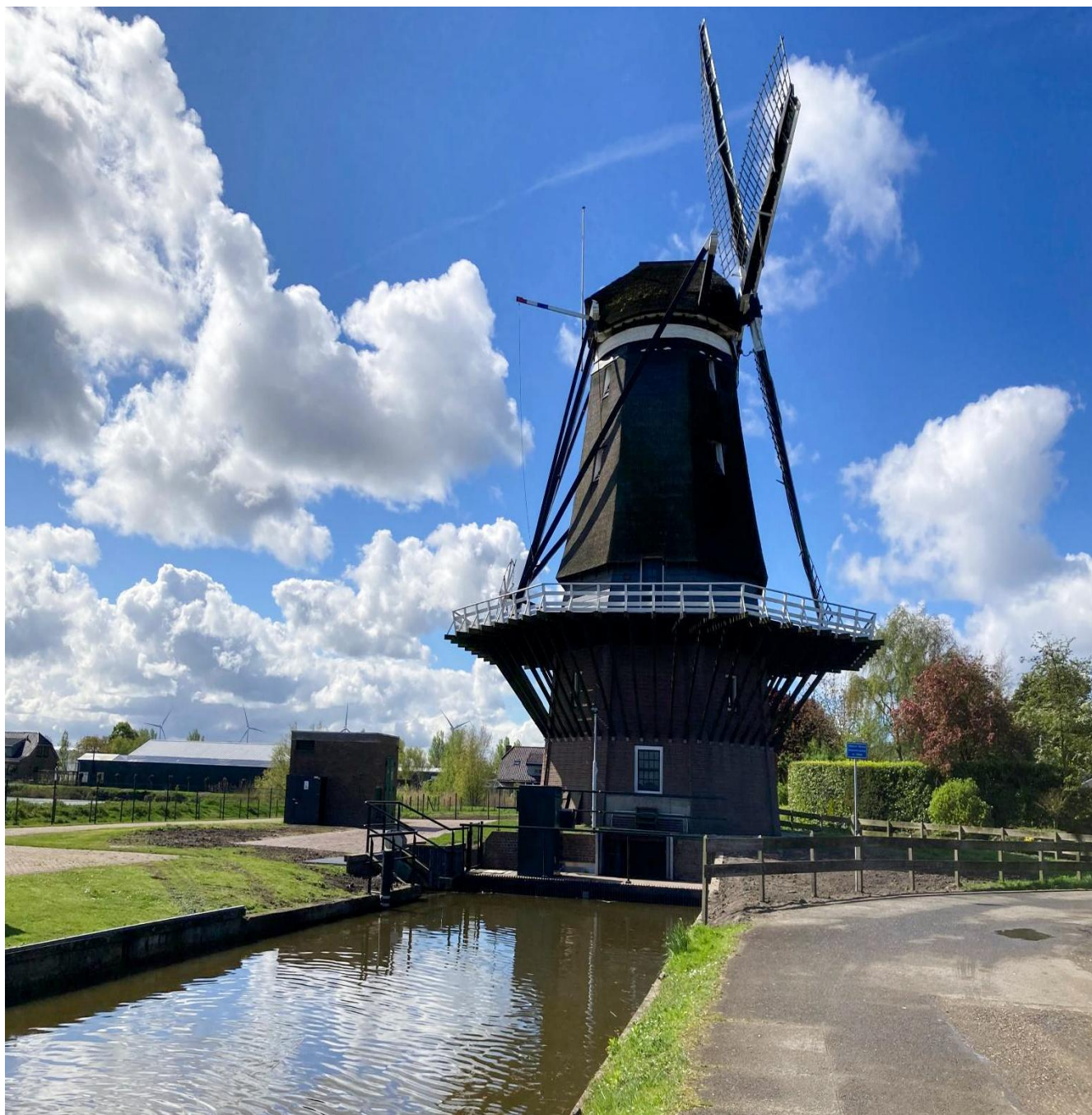
Foto: Nieuwlandse molen met poldergemaal in Hoek van Holland
