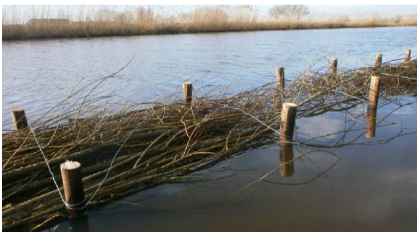
Figuur 11. Vissenbos met een palenrij met onderlinge afstand van 1 meter. IJzerdraad verbindt de palen zigzag aan elkaar, waardoor een stevige constructie ontstaat en de takken bijeen worden gehouden.
