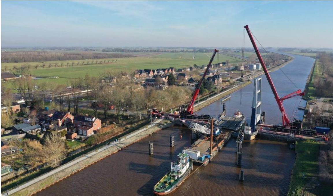
Afbeelding 5.5 Hergebruik brug. Bron: Bruggenbank 2
