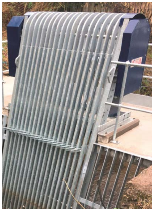
Figuur 3.7 Foto voorbeeld van kettingreiniger (bron: landustrie.nl)
