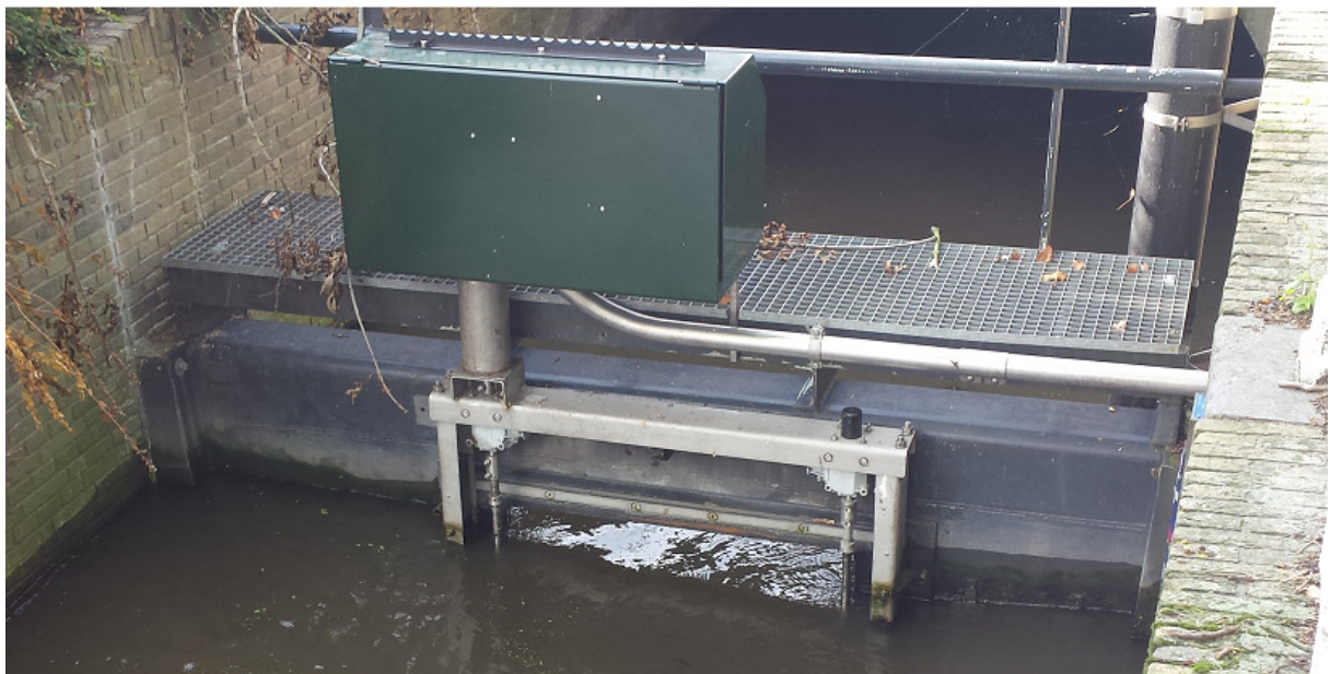
Figuur 11: Nu luchtvoerende aangepaste afsluiter aan de Vlamingsstraat
