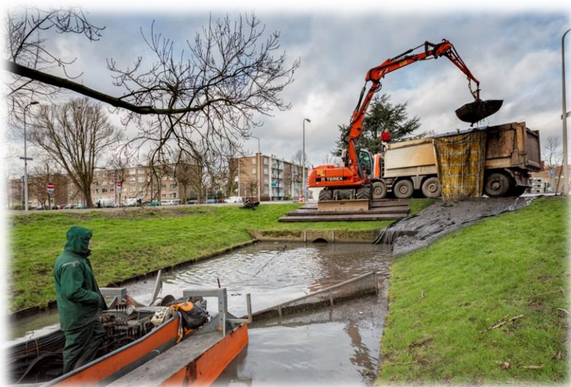
Figuur 51: Baggeren aan de Vrederustlaan in Den Haag. (Benschop, Baggeren)
