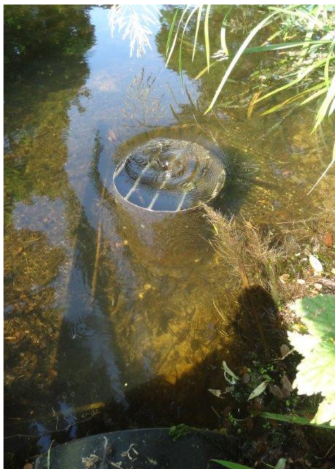
Figuur 4: Voorbeeld kroosslurper bij Rijn en IJssel
