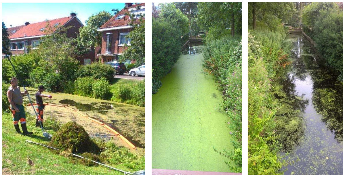
Figuur 4 a) het kroos wordt bij elkaar getrokken met een sleepnet; b) Sloot vol met kroos c) na kroosverwijdering blijven nog dunne resten en kiemen achter, deze zijn niet te verwijderen met de huidige werkwijze
