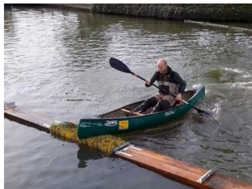
Figuur 6.5 Vuil-werende kanogoot
