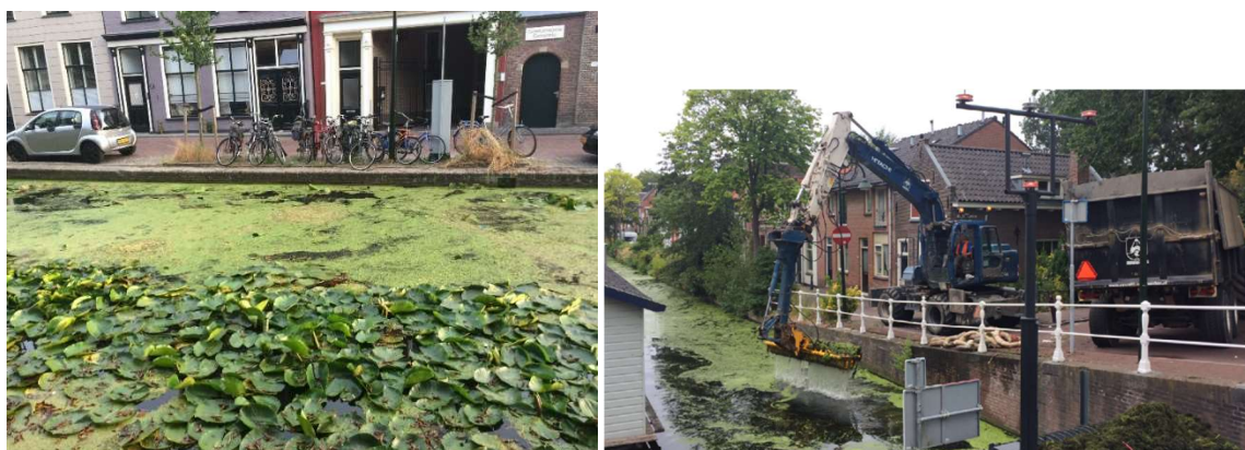
Figuur 44: Links: kroos hoopt op aan het Oosteinde door drijfbladvegetatie en drijflagen; Rechts: kroos dat bij gemaal Duyvelsgatbrug is verzameld wordt in een truck geladen.
