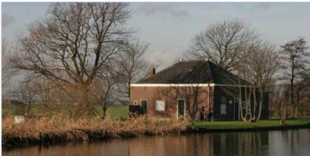
Afbeelding 13 Het Duifpoldergemaal aan de Vlaardingervaart
