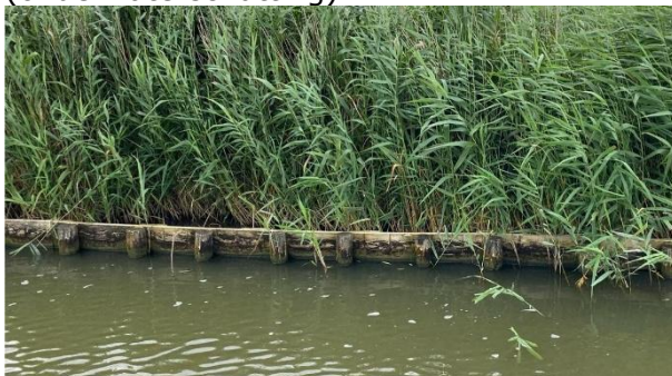
6b. Palenrij met houten planken (onderwaterschutting)
