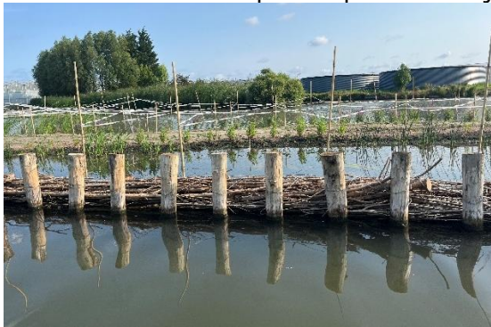
6b. Palenrij met houten planken (onderwaterschutting)
