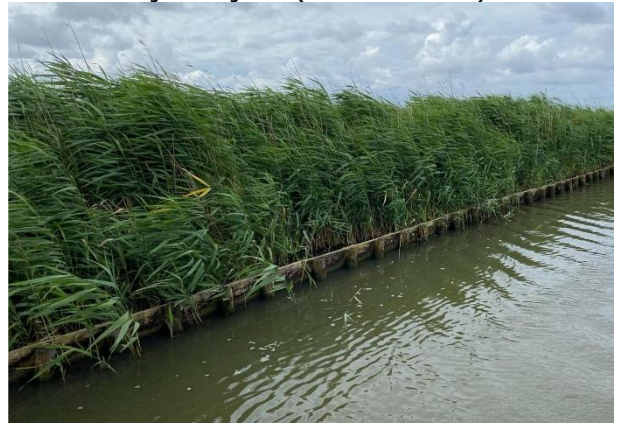
5&6. Damwand met wilgentenen
