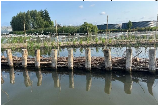
6b. Palenrij met houten planken (onderwaterschutting)
