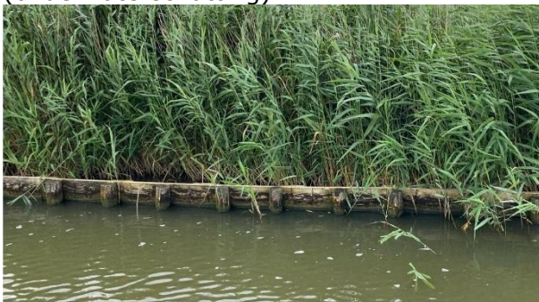
6b. Palenrij met houten planken (onderwaterschutting)
