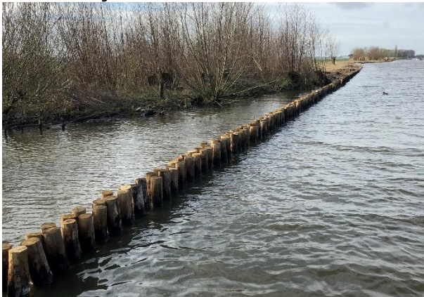
4c. Gebonden wilgentenen golfbreker, deels met en deels zonder plank op de waterlijn
