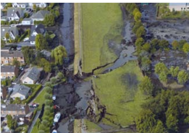
Figuur 2.3.8 Kade in Wilnis bezweken als gevolg van uitdroging veendijk (2003)
