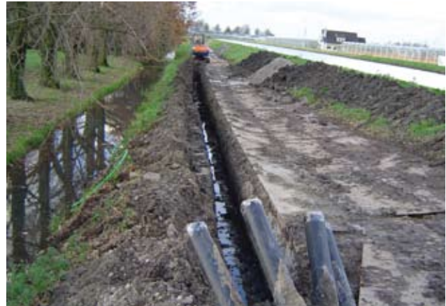
Figuur 6.5.1 Kabels en leidingen in kade
