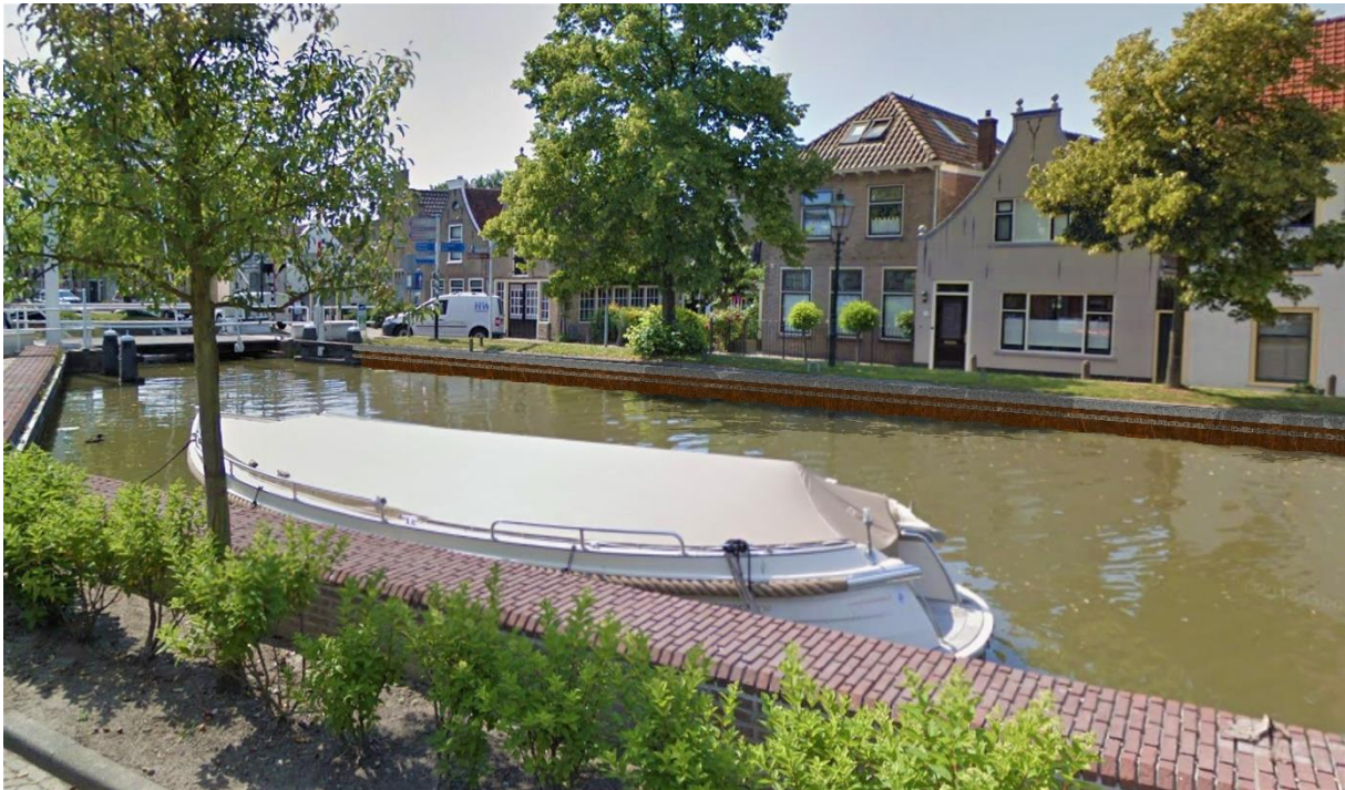
Figuur 1 Zicht op nieuwe constructie in kadevak 1
