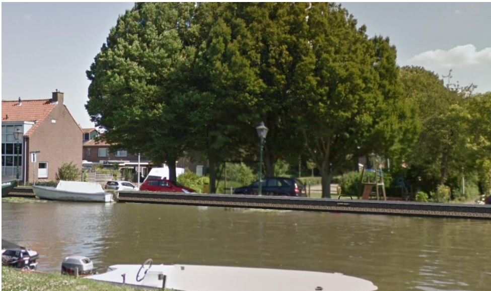
Figuur 4 Zicht op nieuwe constructie in kadevak 4
