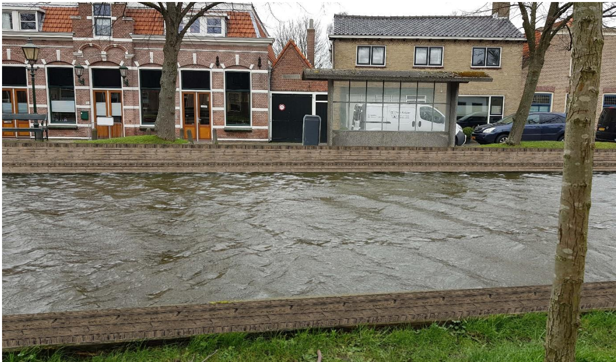
Figuur 2 Zicht op nieuwe constructie in kadevak 2
