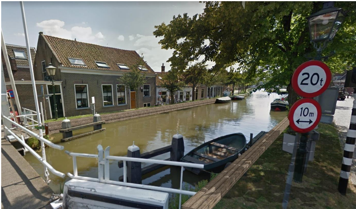
Figuur 3 Zicht op nieuwe constructie in kadevak 3
